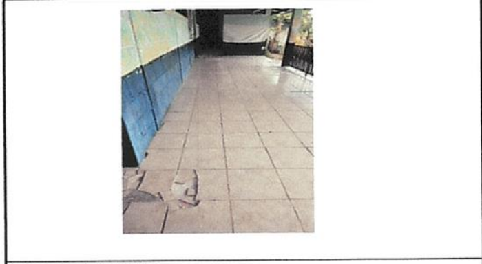
Foto 2: Cambio de Piso
