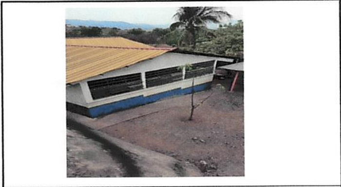
Foto1: Sustitución de pintura de todo el centro educativo.
