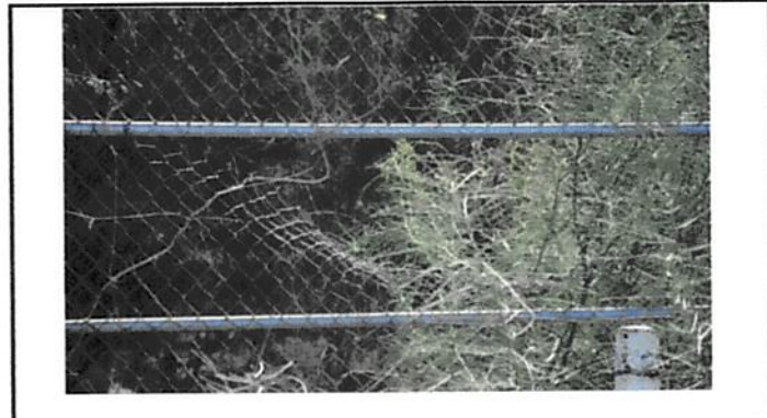
Foto 4: Sustitución de malla.
